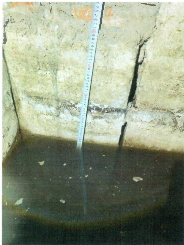
Фото 3 На всей площади подвала блока I (подъезды 1, 2) имеется скопление воды глубиной 180 мм (на момент обследования)
