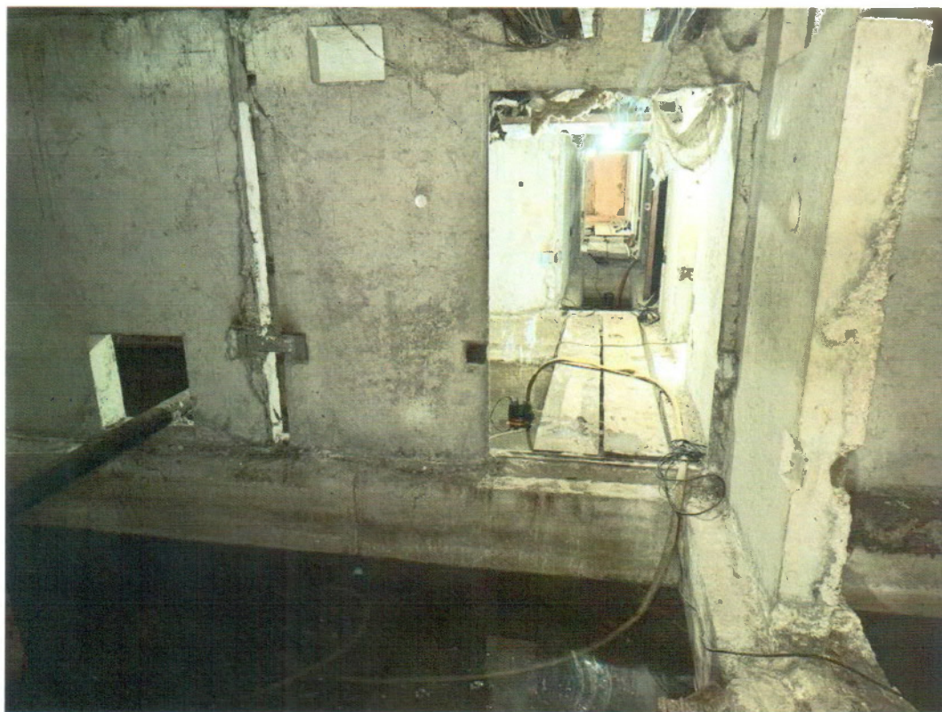
Фото 2 Общий вид подвального помещения
