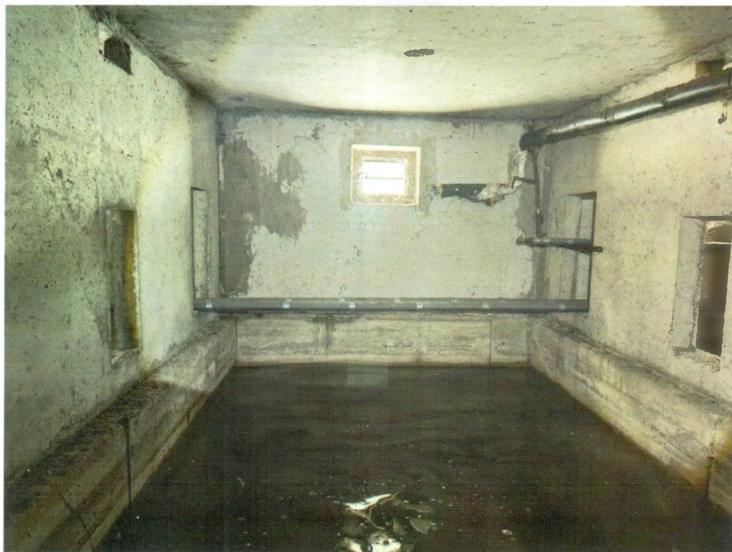
Фото 1 Общий вид подвального помещения
