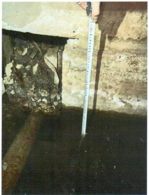
Фото 3 На всей площади подвала блока I (подъезды 1, 2) имеется скопление воды глубиной 180 мм (на момент обследования)
